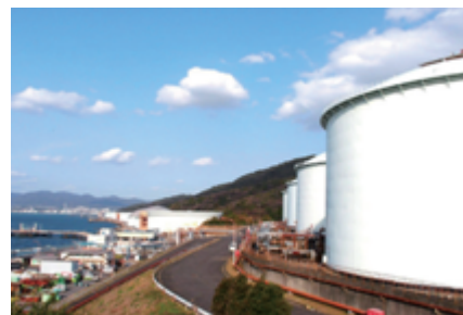
徳山事業所（アンモニア貯蔵検討を進めているLPGタンク）
